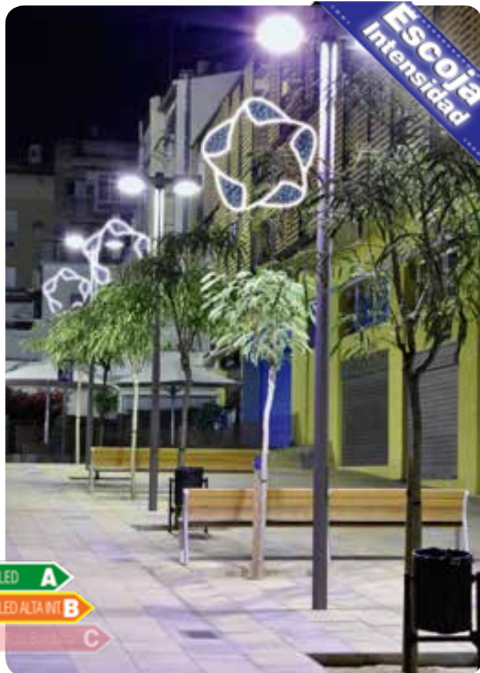
Montaje en farola de 1 unidad de figura "Molinillo". Figura rellena de guirnalda Led de color azul bajo pedido.
